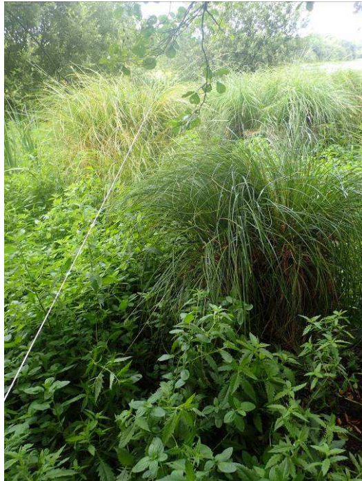
▲ Vue de la ligne depuis l'amont
