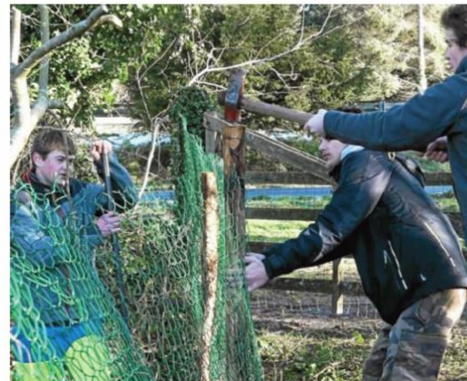
Les étudiants du lycée de Suscinio, de Morlaix, ont participé aux travaux sous la conduite de David Menanteau, de LTC.
